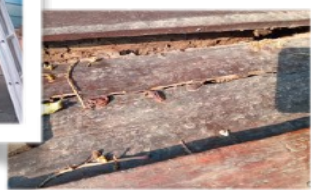
Detailopname van het te vervangen hout.
